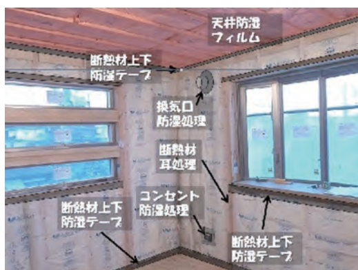
画1 室内気密断熱施工イメージ
