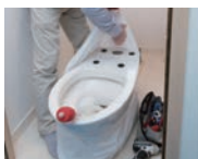
1 養生・既存便器撤去
