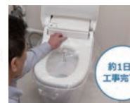
6 通水・排水検査・試運転
