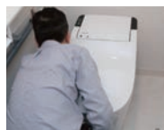
4 アラウーノ本体設置
