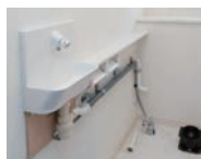
3 手洗い・カウンター設置
