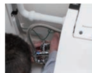
5 給水・電源・接続
